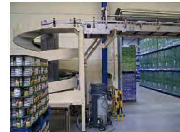
Om het heftruckverkeer door de nieuwe opening mogelijk te maken, werden twee spiraalconveyors opgenomen in het transportsysteem
